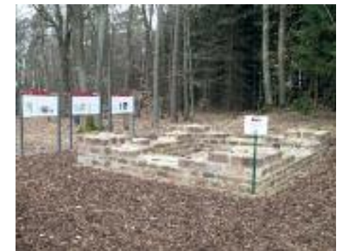
Reichartshausen — Wachturm WP7/13 Reichartshausener Hagwald Wachturmstelle ganztägig zugänglich; Limesführer dort für Erläuterungen und Gespräche von 11 bis 17 Uhr anwesend
